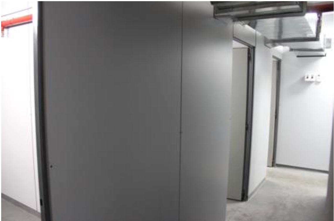
Pasillo que comunica a las tres Salas para mantenimiento de Animales de Laboratorio, con sentido único de circulación. Cada una de las tres Salas de Animales cuenta con un sistema de renovación y acondicionamiento de aire (al fondo se observa el comando de regulación).
